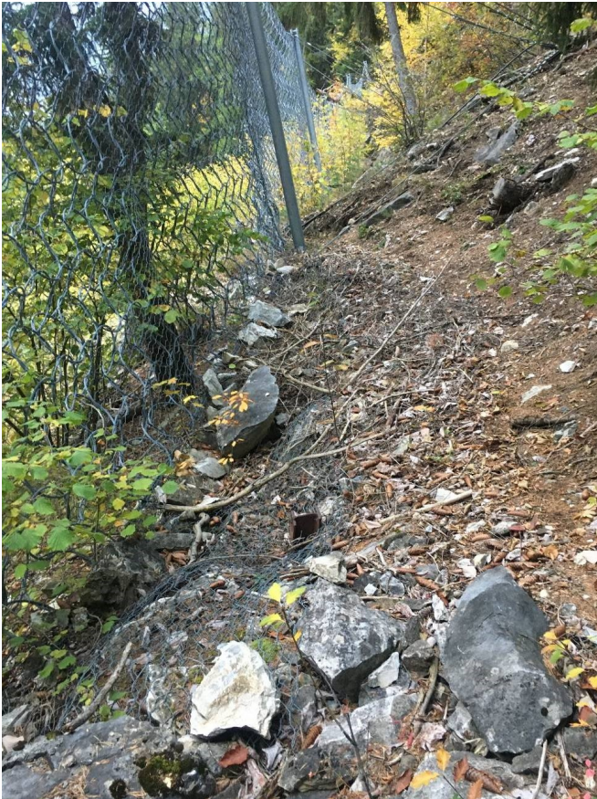
Figura 12: barriera paramassi alla base dello sperone roccioso
