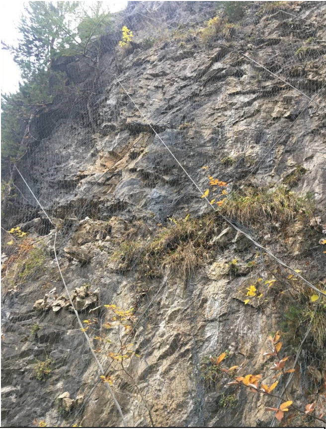
Foto 8: disposizione delle reti in aderenza alla roccia
