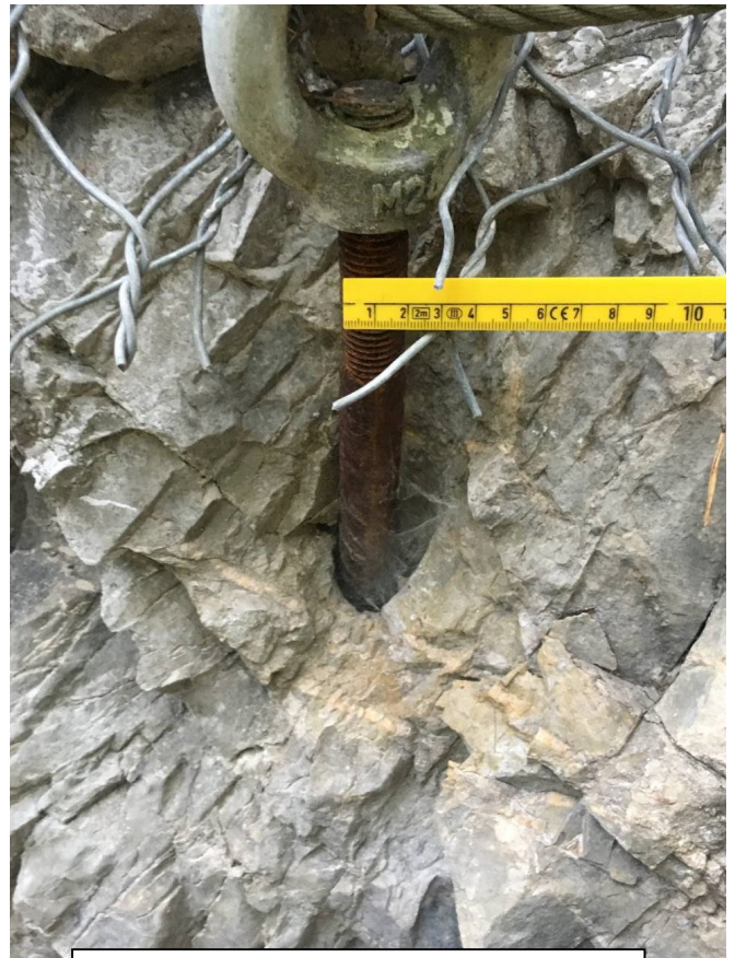
Foto 9: particolare del chiodo di ancoraggio
